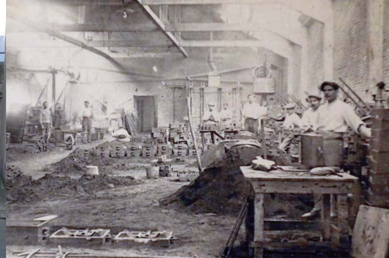
Site du couvent des Récollets, Fonderie Fatz, intérieur des bâtiments avec les ouvriers préparant les moules, première moitié du XX e siècle.
